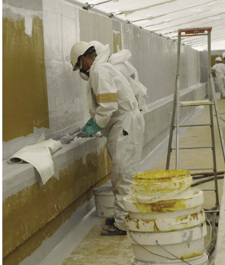
Travaux de réfection dans le bassin de rétention recouvert d'une bâche après mise à nu du béton
