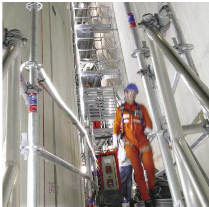
→ Travaux d'étanchéité dans le bâtiment réacteur
