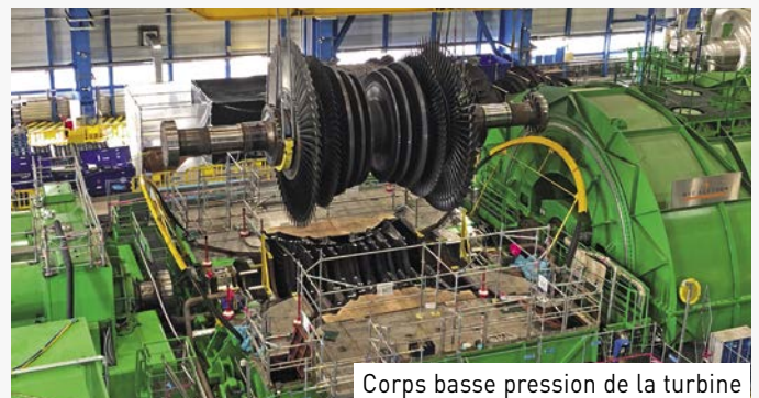
Corps basse pression de la turbine
