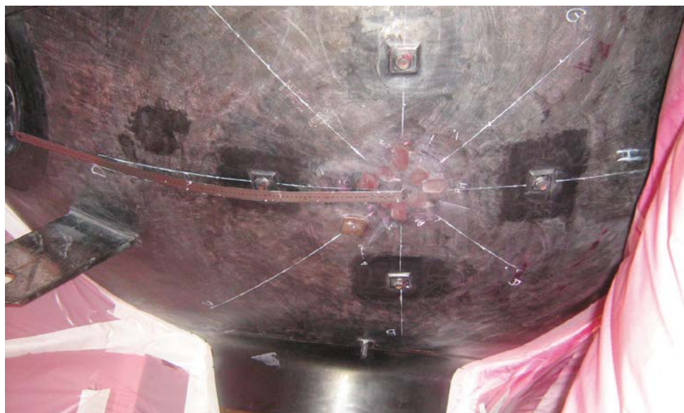
→ Traçage du guide de mesures sur un générateur de vapeur
