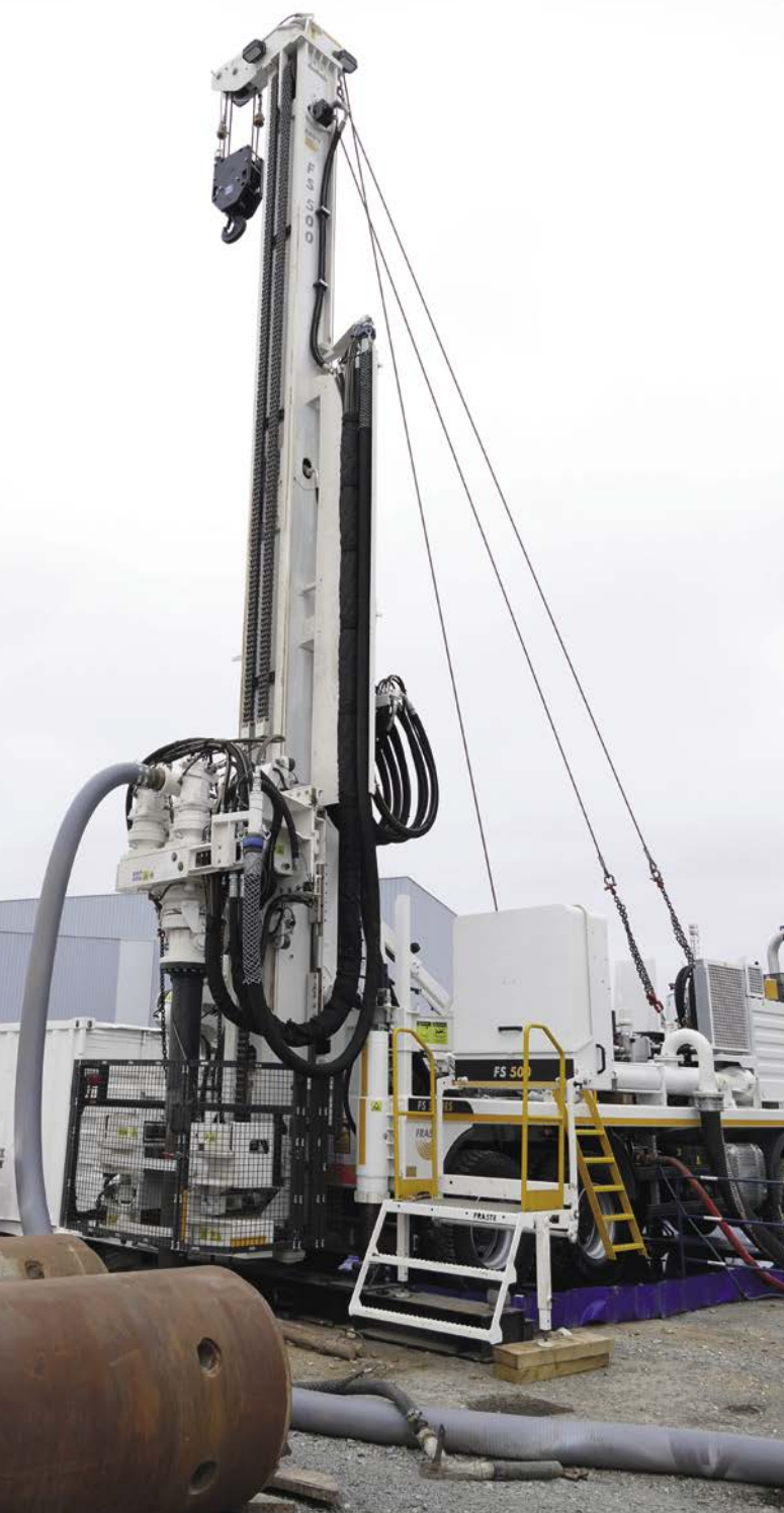
Chantier de forage de la source d'eau ultime
